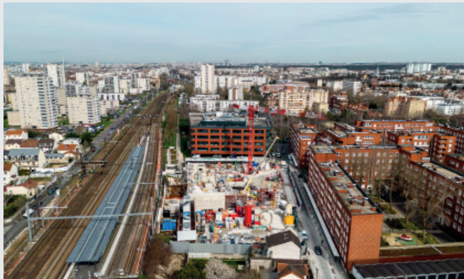
Grand Paris, Gare du Vert-de-Maisons : une cathédrale inversée à plus de 70m de profondeur ! ©Cédric Helsly / Soletanche Bachy
