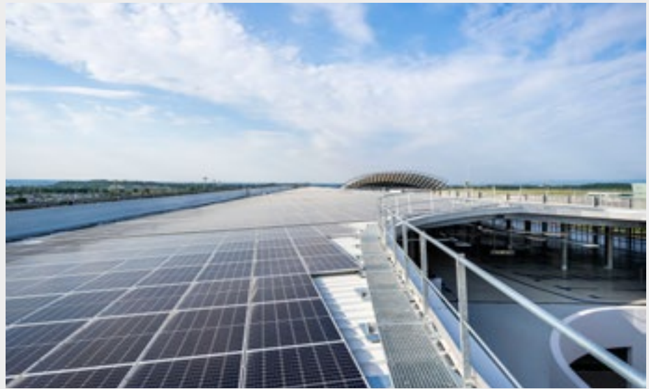
P3 de l'aéroport de Lyon Saint Exupéry livré en avril 2022 avec 1950 places. Bâtiment à énergie positive de 6000 m 2 de PV pour une puissance crête de 960 KVA.
