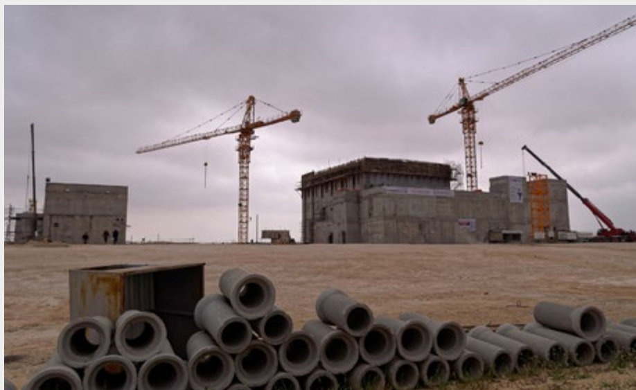
Construction d'un réacteur de recherche en Jordanie - Jordan Atomic Energy Authority.
