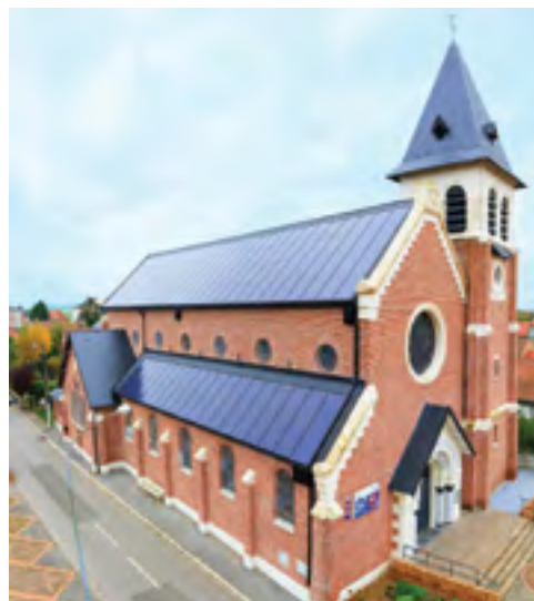
L'église Saint-Vaast couverte de panneaux photovoltaïques.
