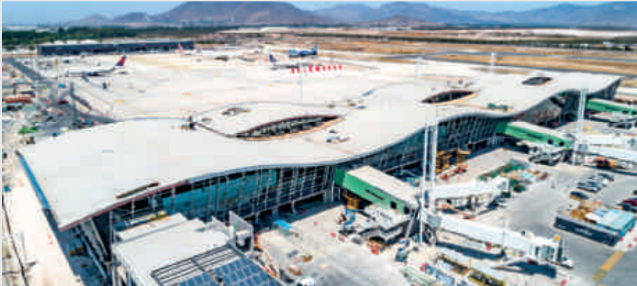
Grâce aux travaux de modernisation et d'agrandissement menés en full-BIM, l'aéroport de Santiago, au Chili, offrira 67 portes d'embarquement et 70 nouveaux kiosques d'enregistrement en libre-service.
