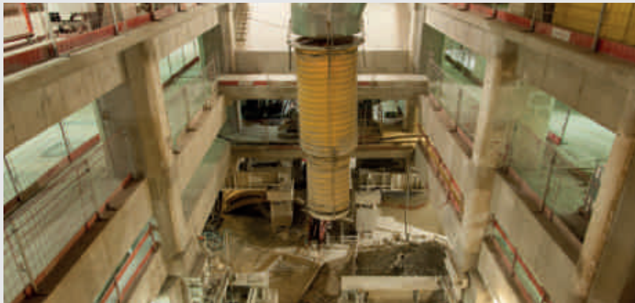
Gare du CNIT - Projet Eole - Prolongement de la ligne du RER E vers l'ouest de Paris.
