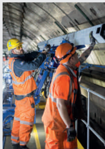
Pose du monorail en Tunnel.
