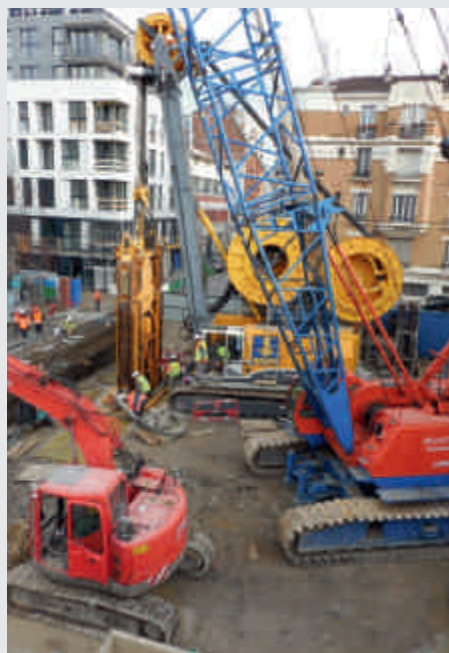
Ligne 14 Nord – Rue Klock
