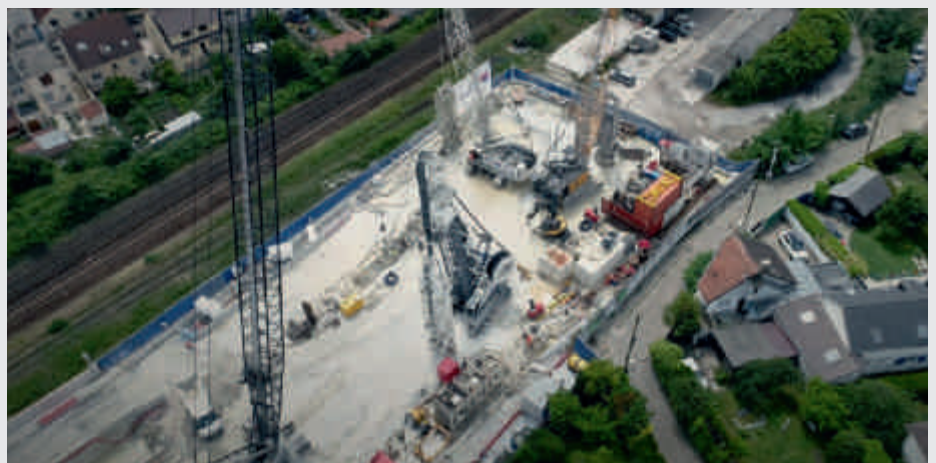
Ligne 15 sud - Lot T2C
