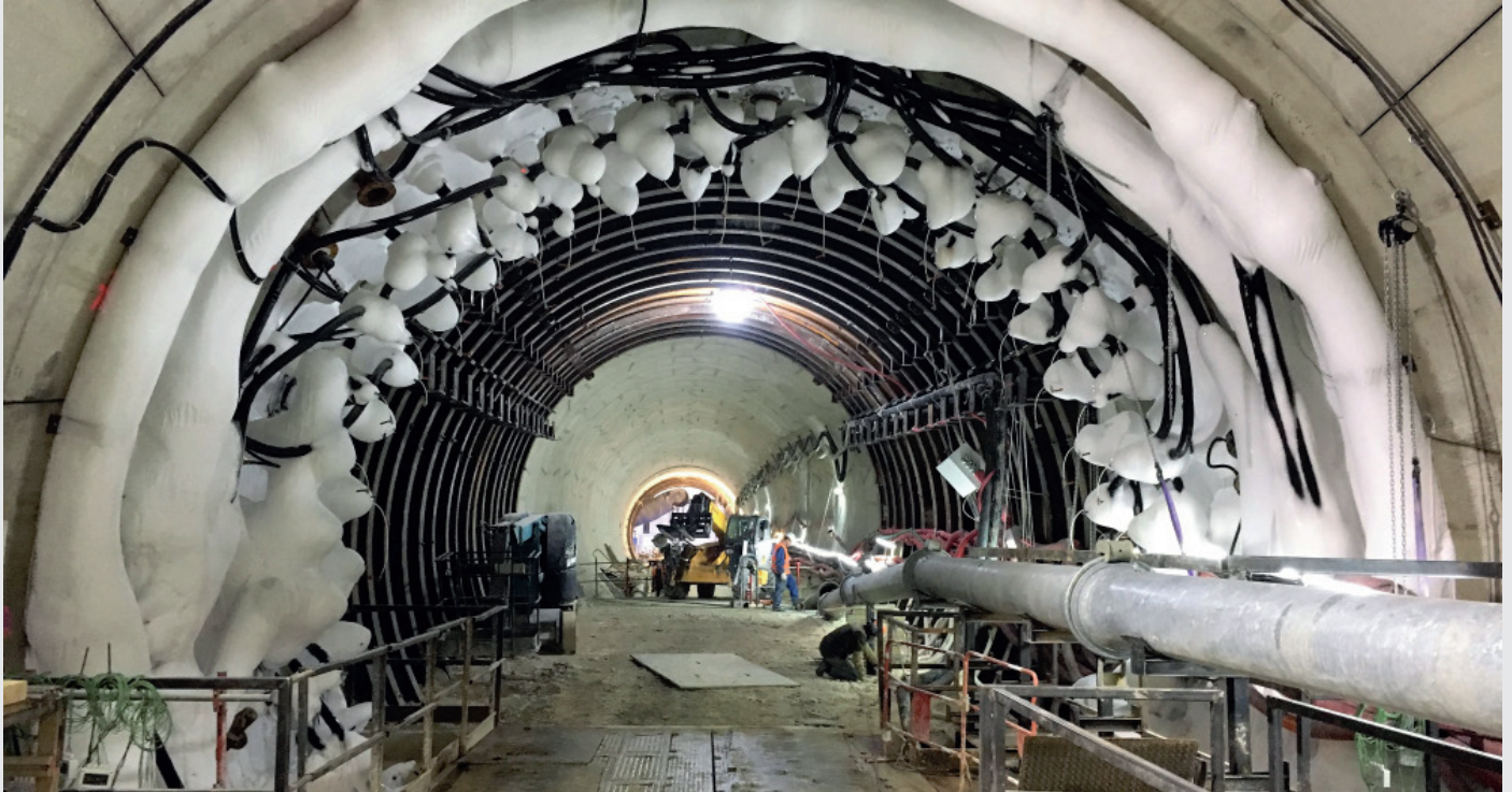
Prolongement de la ligne 12 du métro parisien (phase de congélation du tunnel).
