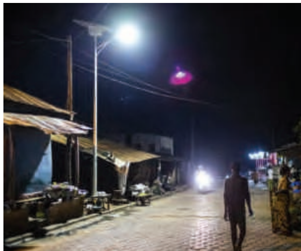
← Installation de panneaux photovoltaïques.
