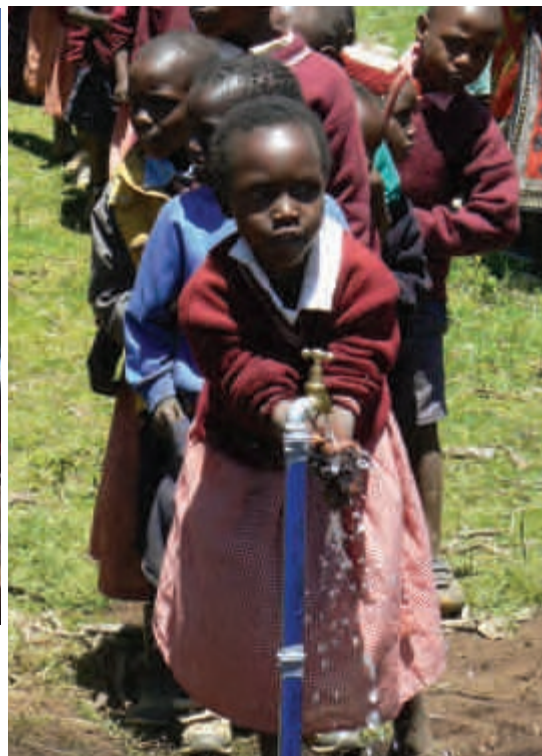
→ Installation d'une fontaine d'eau potable en 2011 au Kenya.
