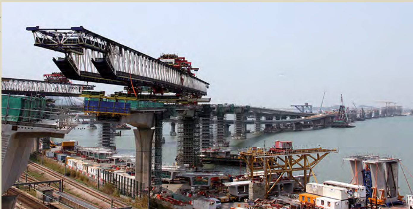
Construction du viaduc Sud du projet TMCLK à Hong Kong.
