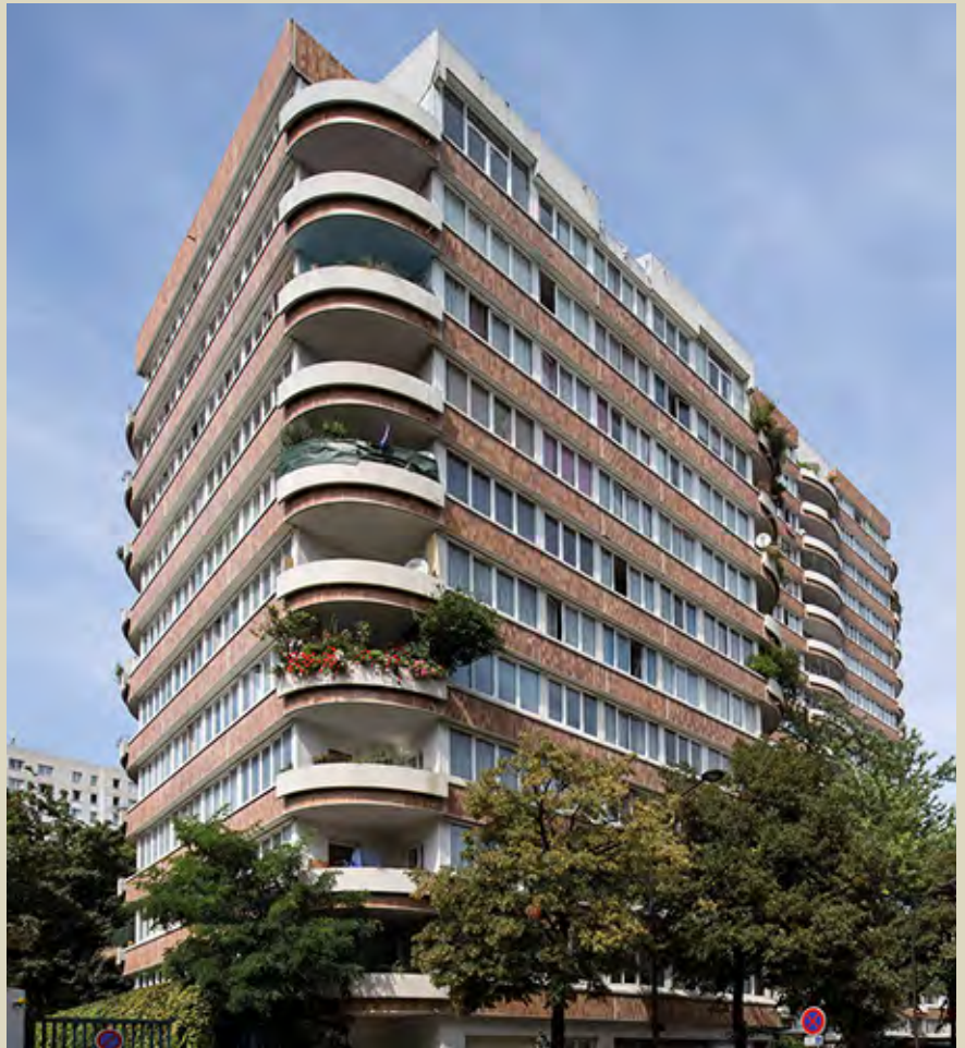
Enerlis a réalisé un site-pilote pour Immobilière 3F, dans lequel il a pu mettre en œuvre un bouquet de solutions d'efficacité énergétique, ce qui a permis de réduire de 30 % les dépenses énergétiques de l'immeuble.
