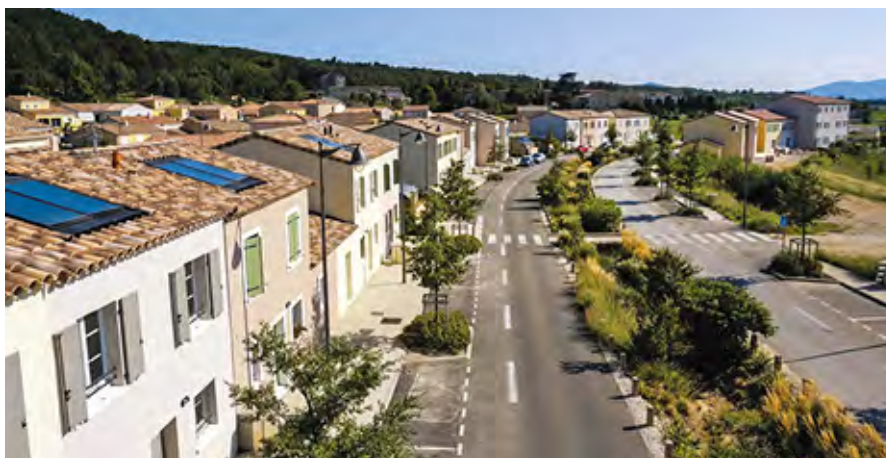
La grande majorité des 350 000 installations photovoltaïques sur toiture aujourd'hui injectent sur le réseau l'intégralité de l'énergie qu'elles produisent.
