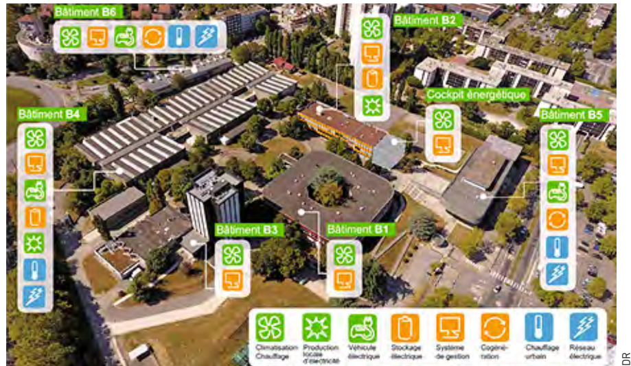
De nombreux réseaux de distribution s'équipent du système avancé dit ADMS.
