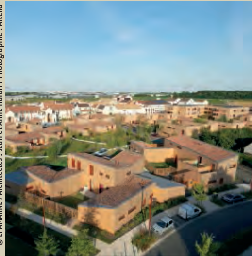
Opération de logements en bois (3F) à Chanteloup-en-Brie.
