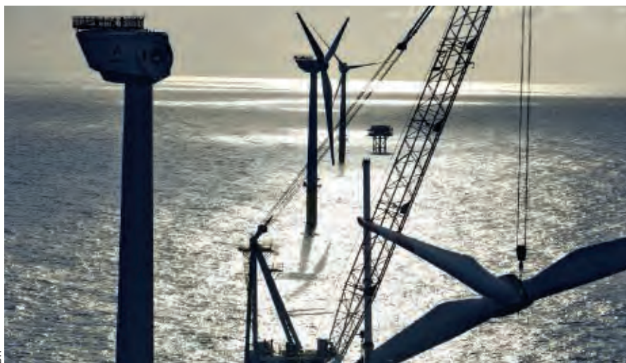
La phase la plus délicate de l'installation, le montage du rotor en « étoile ».
