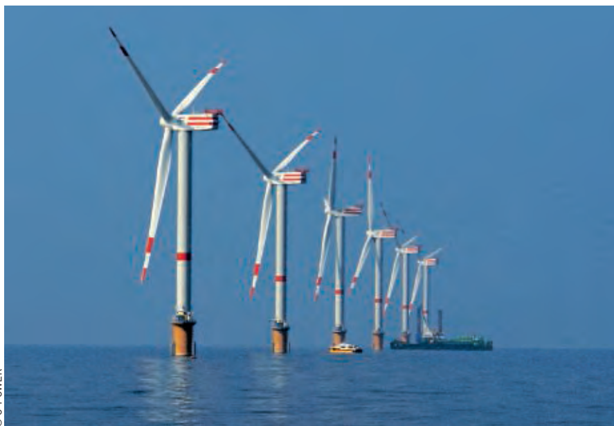
Les éoliennes sont fixées sur le fond à 12 à 27 m de profondeur (parc éolien de Thorntonbank, au large de la Belgique, mis en route en 2009).
