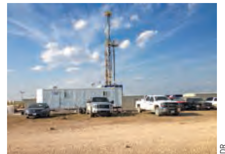
DR Mon travail consiste à superviser la cimentation de puits de pétrole, principalement dans un but d'étanchéité.
