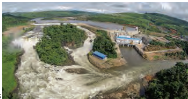
Kaléta, un barrage réalisé en Guinée par China Water and Electric Company et dont la construction a été supervisée par Tractebel Engineering France pour le compte de l'État guinéen, maître d'ouvrage. Ce barrage se trouve à 7 km de Souapiti, le projet sur lequel je travaille actuellement. Les deux ouvrages sont fortement liés.
