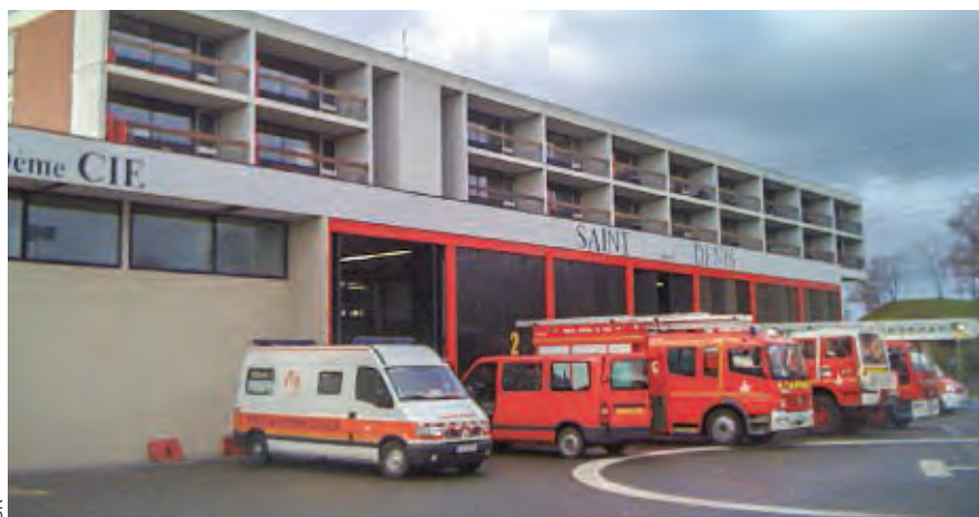
DR Les sapeurs-pompiers peuvent intervenir partout dans la mégapole parisienne en moins de dix minutes.
