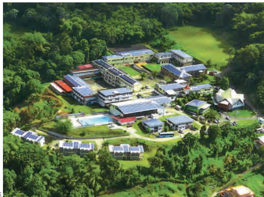
Le site de L'Espérance à Fort-de-France et la centrale photovoltaïque en toiture.
