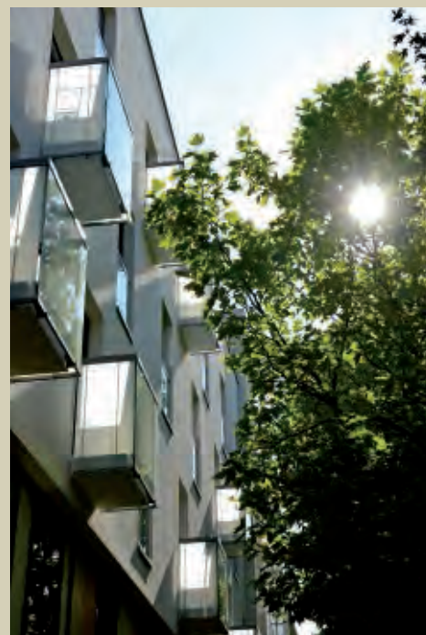
Résidence intergénérationnelle à Bussy-Saint-Georges. Architecte : Cité Architecture.
