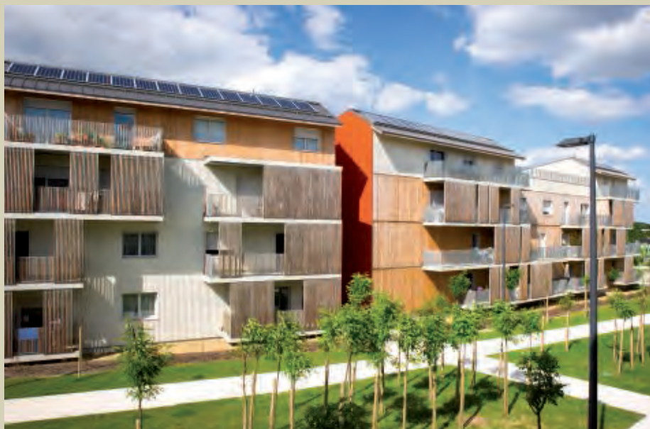
Résidence Le Lavoir – Bordeaux. Architecte : Agence Brochet Lajus Pueyo.
