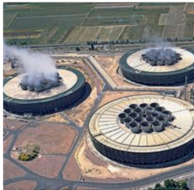
Réfrigérants bas avec ventilateurs à Chinon.
