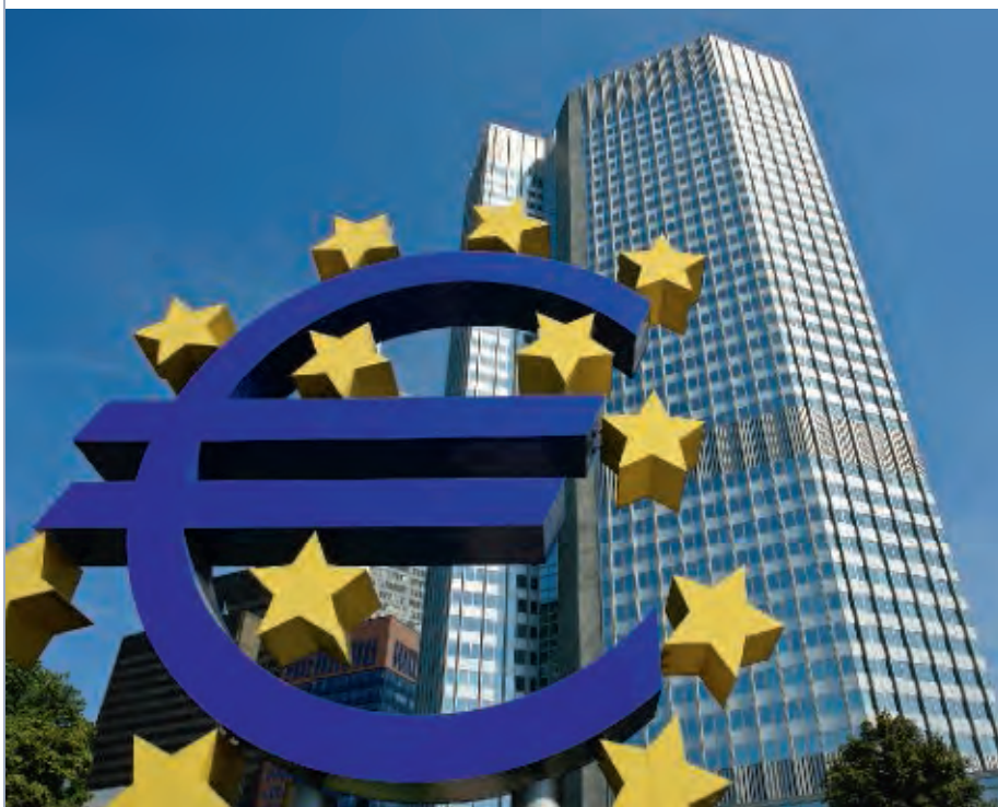
Siège de la BCE à Francfort-sur-le-Main.
