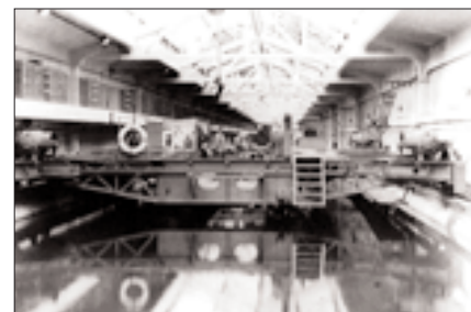
Bassin n° 1 avec sa plate-forme originelle.
