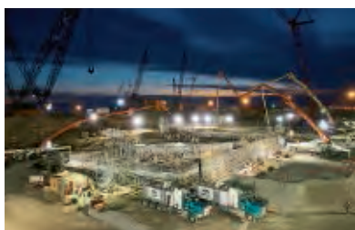
Coulée du radier du réacteur AP1000 de VC Summer (USA), le 6 mars 2013.
