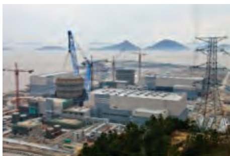
Pose du couvercle de l'AP1000 de Sanmen 1 (Chine) en janvier 2013.
