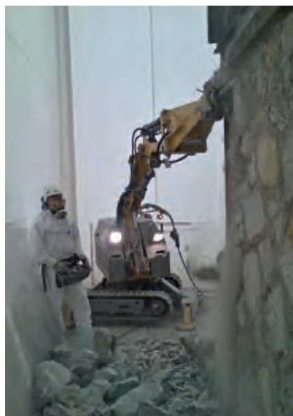
Démantèlement d'un site d'Areva.
