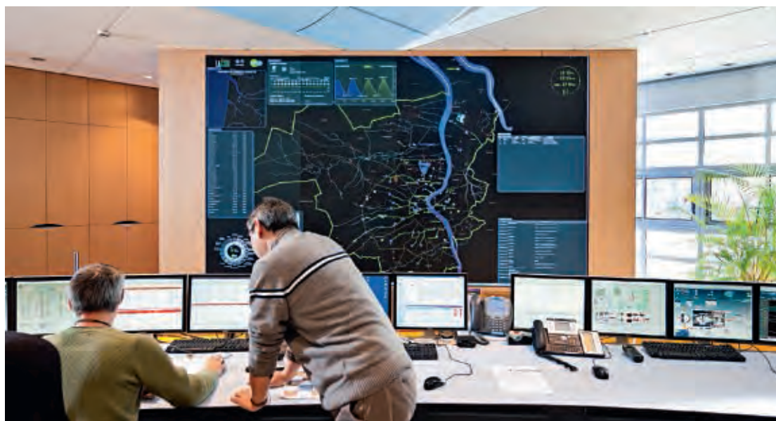
Système Influx (Gestion des eaux pluviales) mis en place sous le nom de Ramses pour la Communauté urbaine de Bordeaux.
