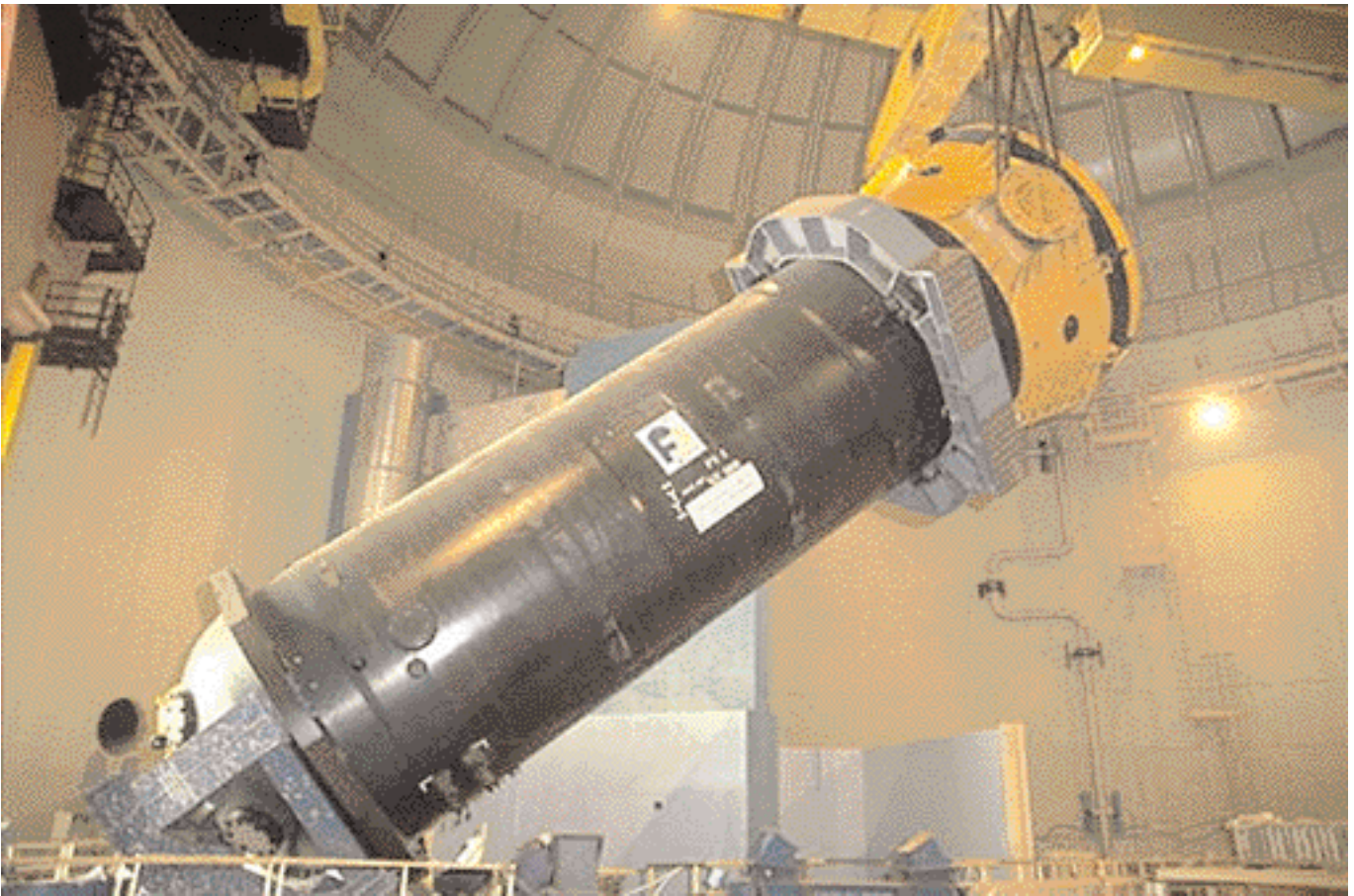
Opération de changement de générateur de vapeur.
