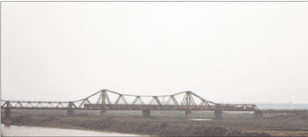
Le pont Doumer à Hanoi.
