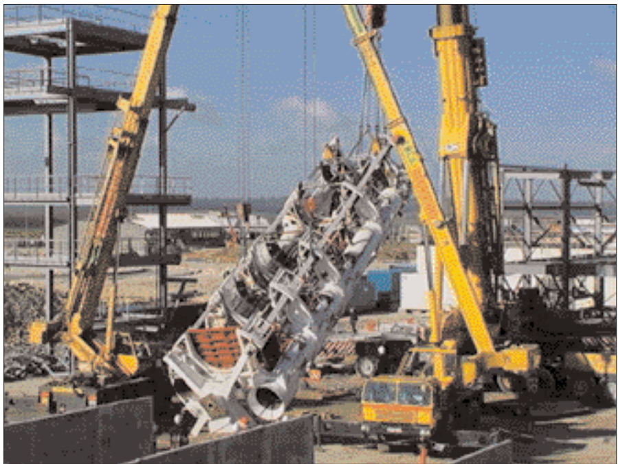
Mise en place du plancher dans le puits d'accès du Laboratoire de recherche souterrain de Meuse-Haute-Marne.
