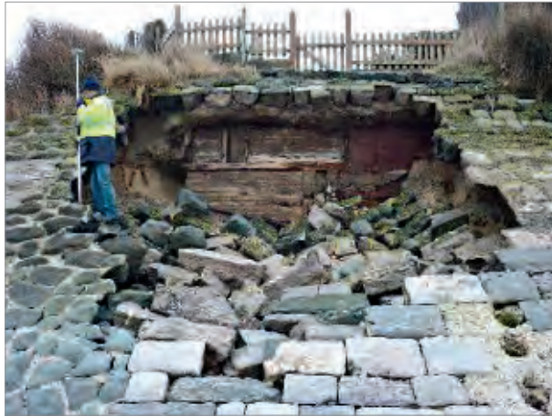
Sangatte, inspection des ouvrages de protection.
