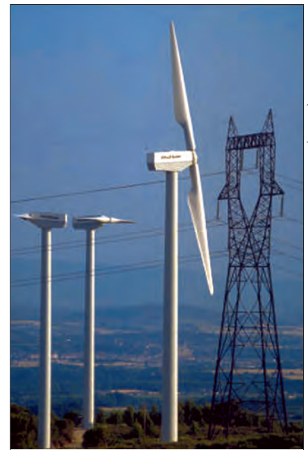
Parc éolien de Limousin : éoliennes et pylone.
