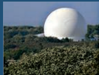
Radome de Pleumeur-Bodou.
