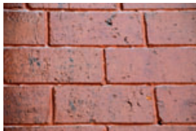
Mur de latérite, roche remplaçant avantageusement la brique en climat tropical (T-ZED, Bangalore).
