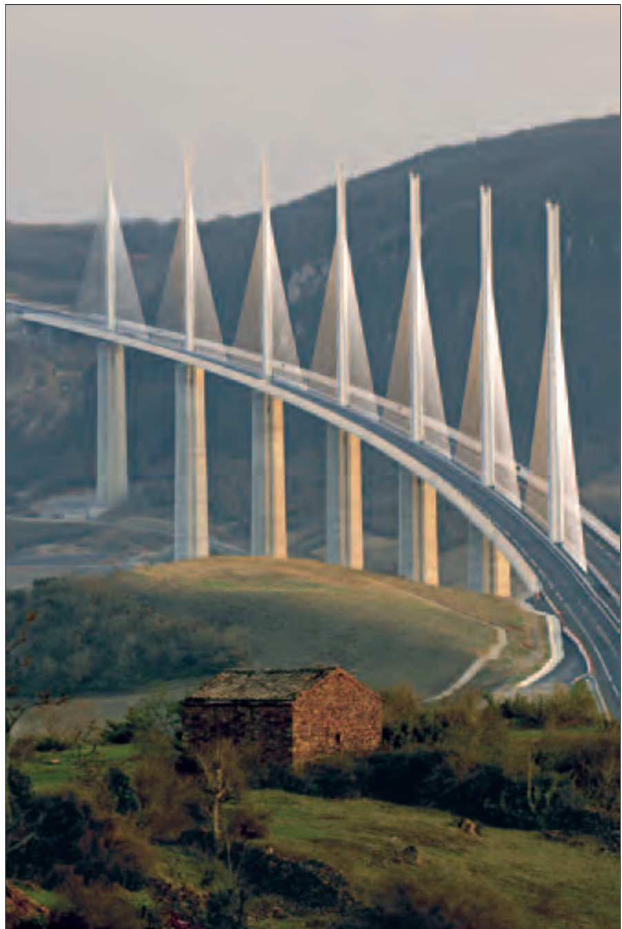
Le viaduc construit.
