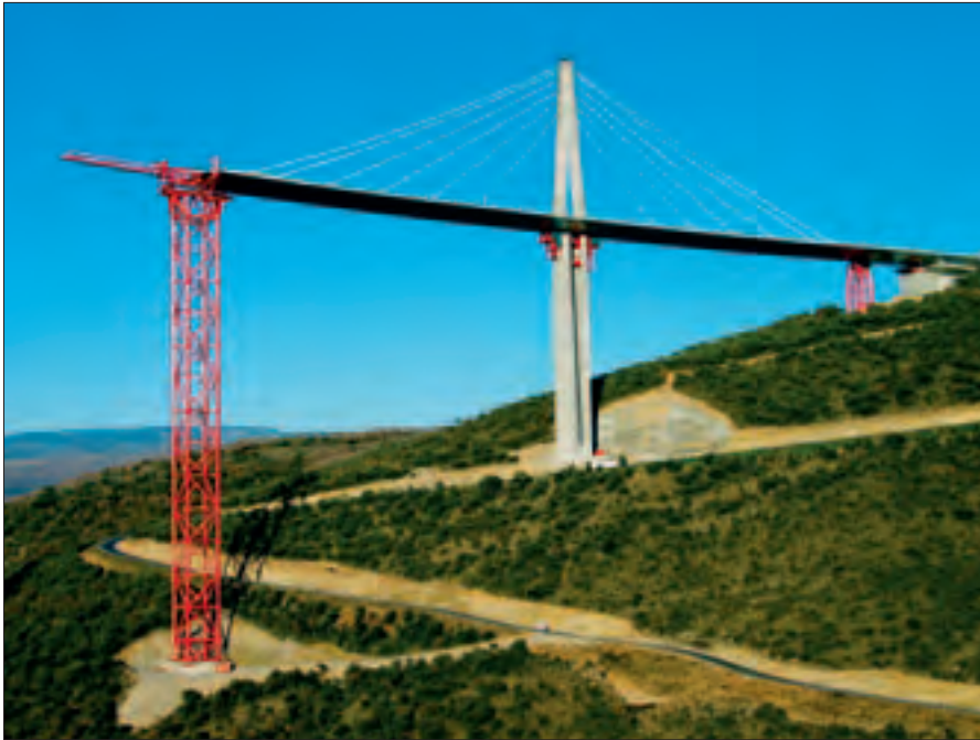
Le viaduc de Millau en construction.
