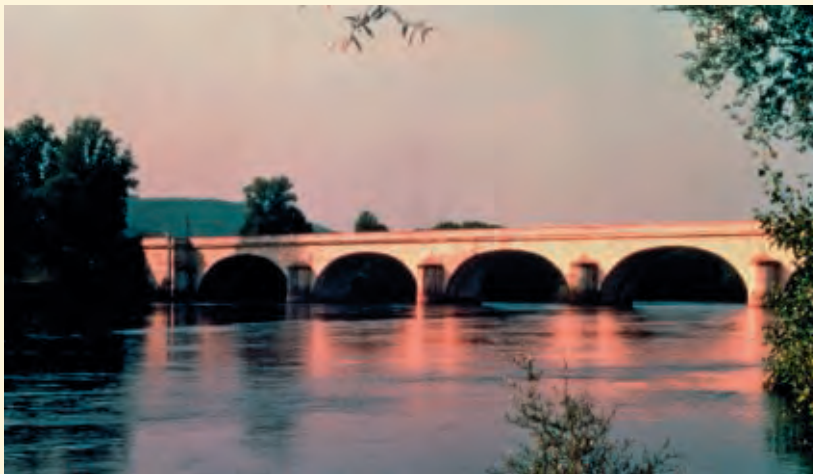
Le pont de Souillac, première construction au monde réalisée avec du ciment artificiel.
