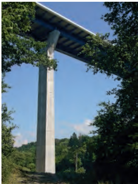
Le viaduc des Usses (A41) avec ses piles majestueuses.
