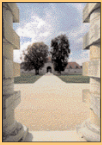
Bâtiment des gardes de la saline royale d'Arc-et-Senans, dans le Doubs.
